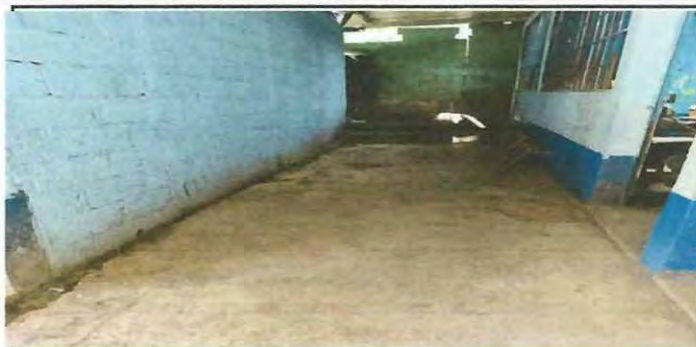
Foto2: SUSTITUCION DE PISO EN PASILLO
