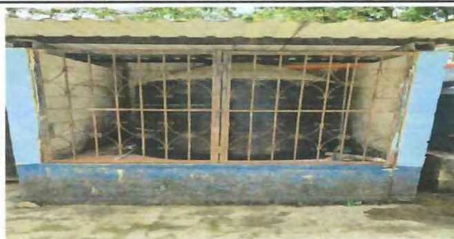
MEJORAMIENTO DE BASE PARA TINACO
