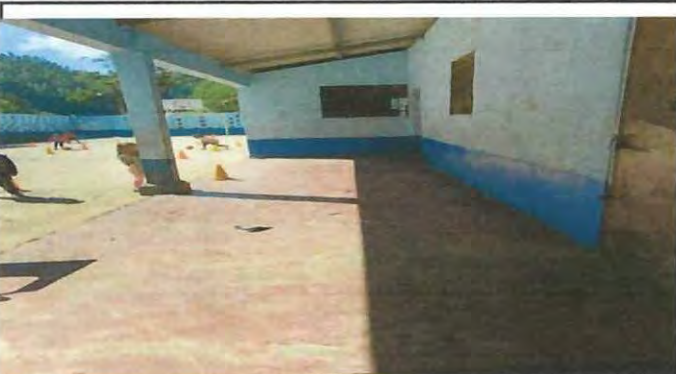
Foto 3: REAPRACION DE VENTANA
